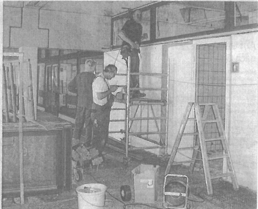
Ernstes Schaffen am Schulzentrum Ilshofen: Lautstarke Arbeiten wie Bohren und Hämmern sollen jetzt während der Ferien getätigt werden. Foto: Kern-Kalinke
