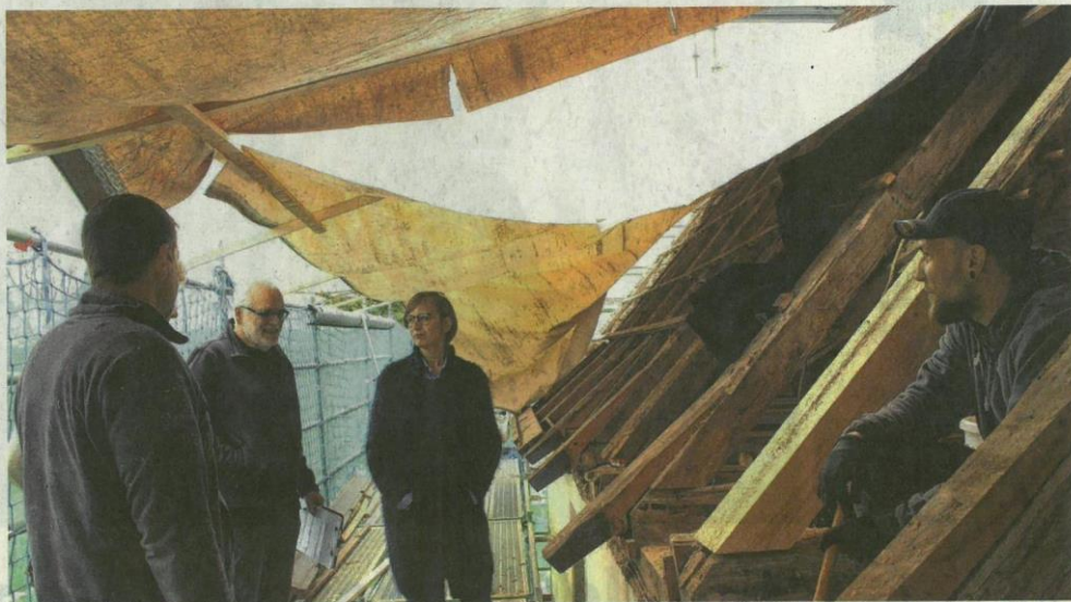
Architektin Sabine Kronmüller auf dem Baugerüst im Gespräch mit Fachplaner Raimund Maier und den Zimmerleuten. Das Dachgebälk ist im Bereich der Traufe freigelegt. Der helle Balken rechts im Bild wurde neu eingesetzt. Foto: Sigrid Bauer
