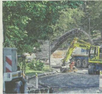
Die Fahrbahn wird zuerst mit einer Asphaltfräse bearbeitet.
