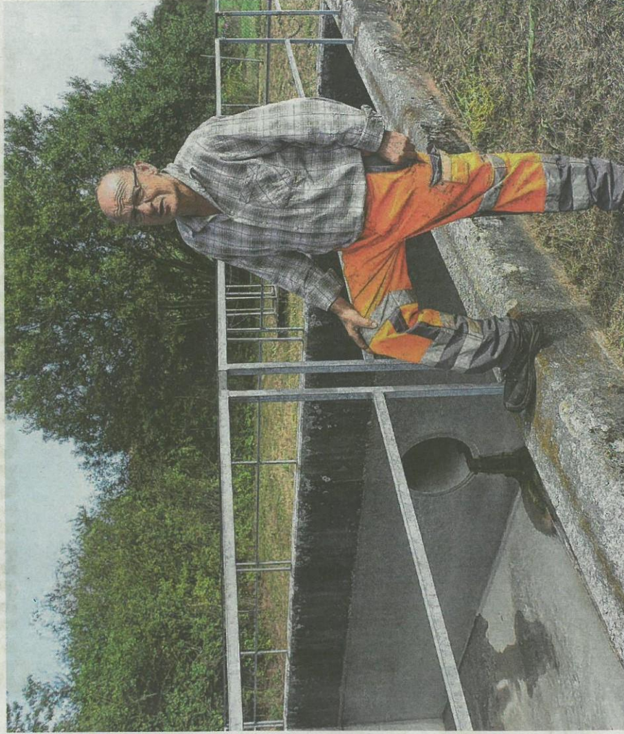
Klärwärter und Bauhofleiter Hartmut Lehr steht am Regenüberlaufbecken Großaltdorf. Es nimmt das Mischabwasser aus Großaltdorf und Lorenzinzimmern auf. Wie die anderen Überlaufbecken wird es mit einer Messtechnik ausgerüstet, die den Füllstand und das Durchflussvolumen angibt. An diesem trockenen Tag der Aufnahme fließt lediglich ein Rinnsal ins Becken.
