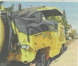
Schweres Gerät fräst den Rosmarinweg auf. Foto: Sigrid Bauer
