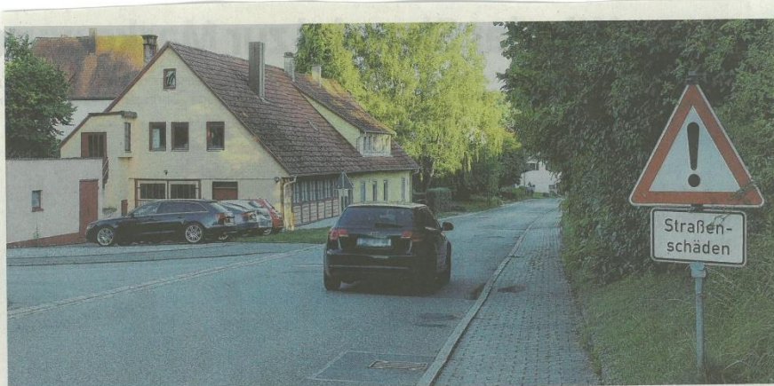
Ein Schild an der Ortsfahrrad nach Großaltdorf aus Richtung Oberspach warnt die Autofahrer vor Straßenschäden. Der Gehweg ist durch Lkw eingedrückt. Foto: Sigrid Bauer
