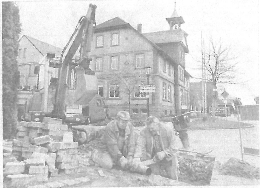
In Littenhofen sind Glasfaserkabel verlegt worden. Das Archivbild zeigt Bauarbeiter vor dem Uttenhofener Rathaus. Bürger in anderen Dörfern im Kreis Hall können von einem schnellen Internet nur träumen. Archivfoto: Thumli
